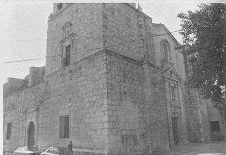
La iglesia vista desde el ángulo noroeste, en la calle Mercedes.
