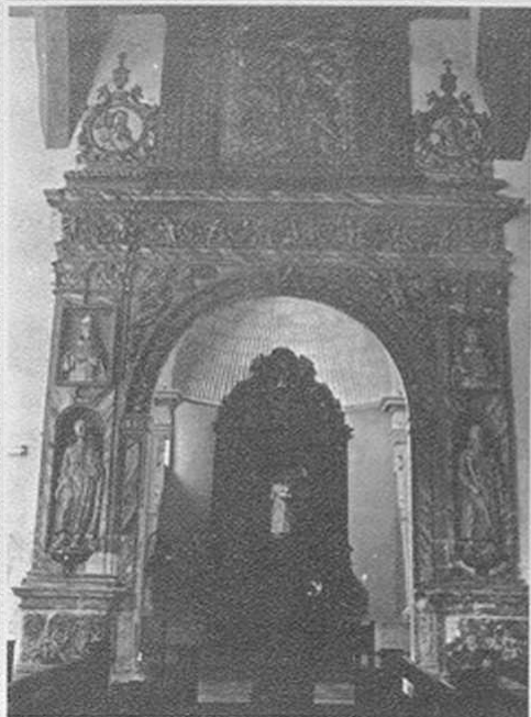
La entrada a la capilla del Rosario tiene forma de arco de triunfo (izquierda). Detalle de las bóvedas de la iglesia del Convento (derecha).
