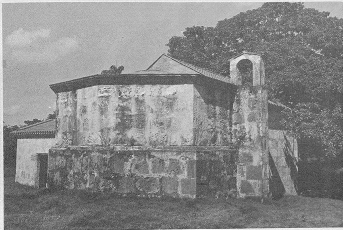
La capilla del ingenio, restaurada, con su pequeño campanario que es a la vez contrafuerte y el robusto ábside de piedra.
