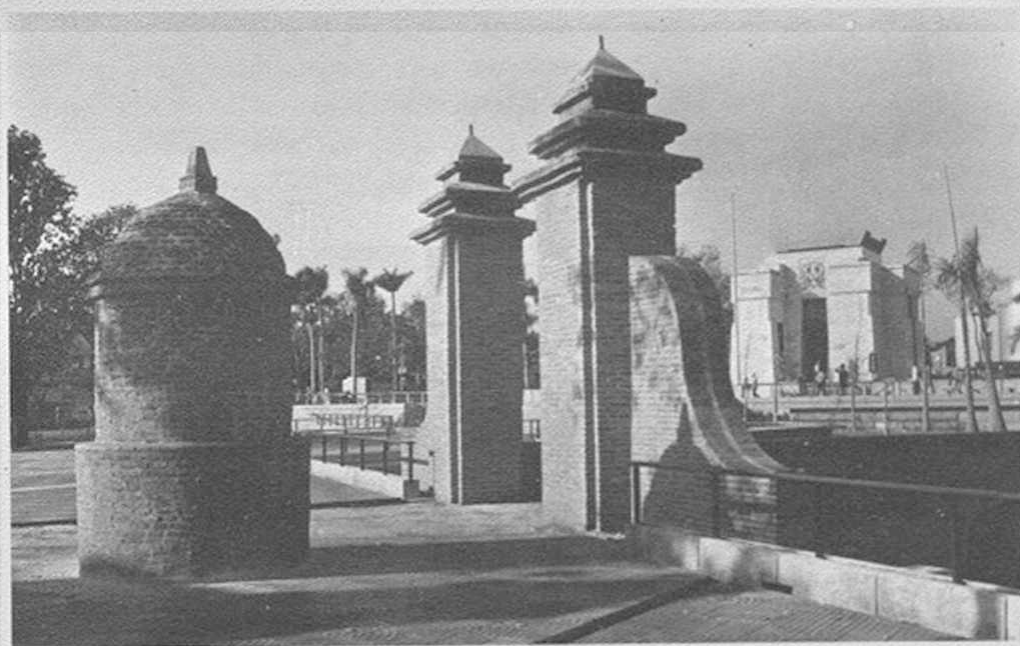
Puente de ladrillo reconstruido. Al fondo, el panteón de los Padres de la Patria.
