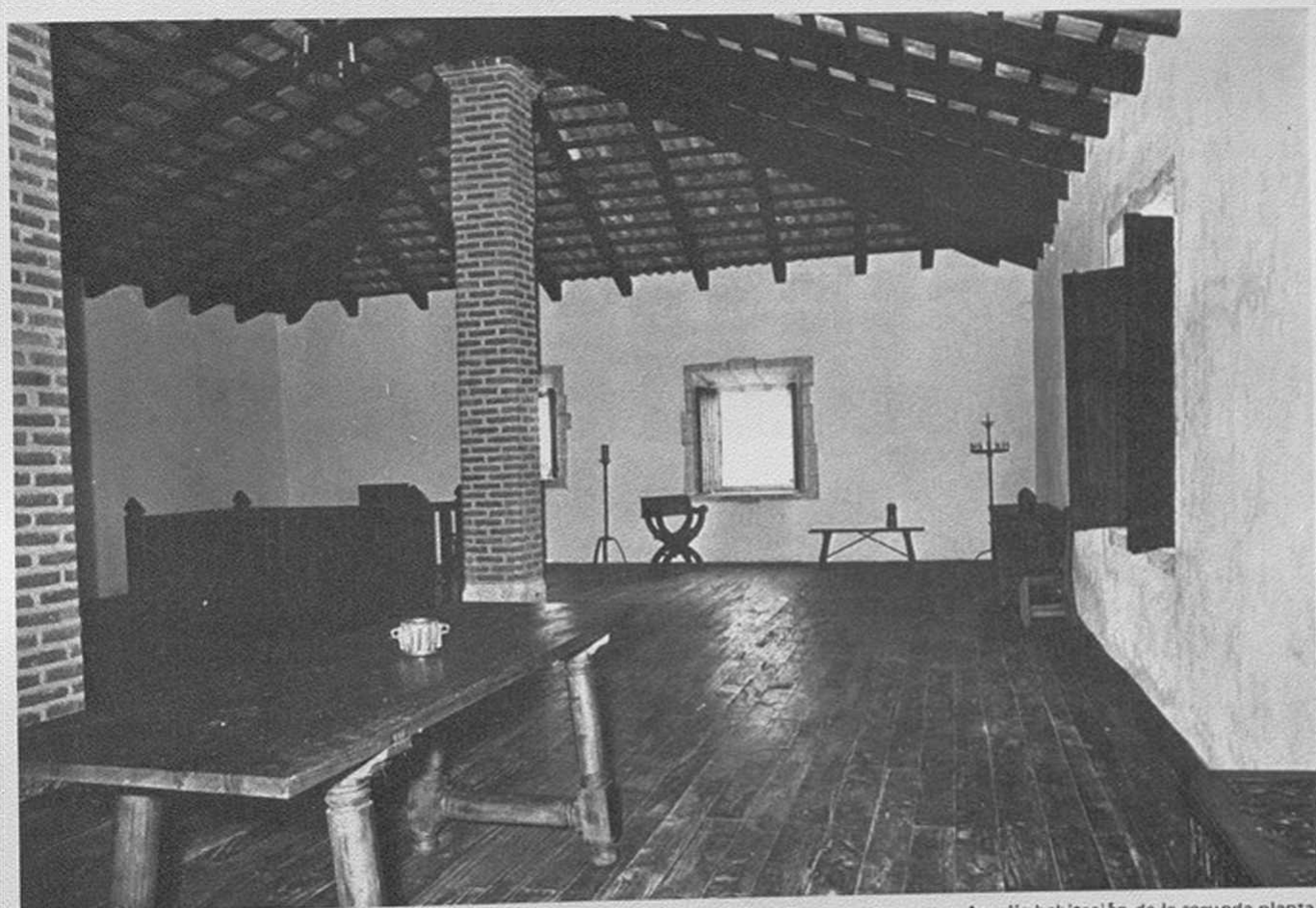
Amplia habitación de la segunda planta, cubierta de un techo de ladrillo de cuatro aguas de gran inclinación.
