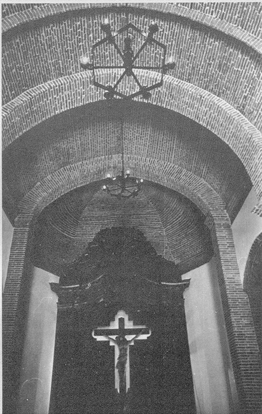
El ladrillo, trabajado con pericia, es el material de las bóvedas de la capilla de San Andrés.
