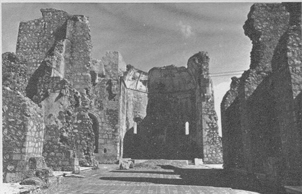
Interior de la iglesia con el presbiterio al fondo.
