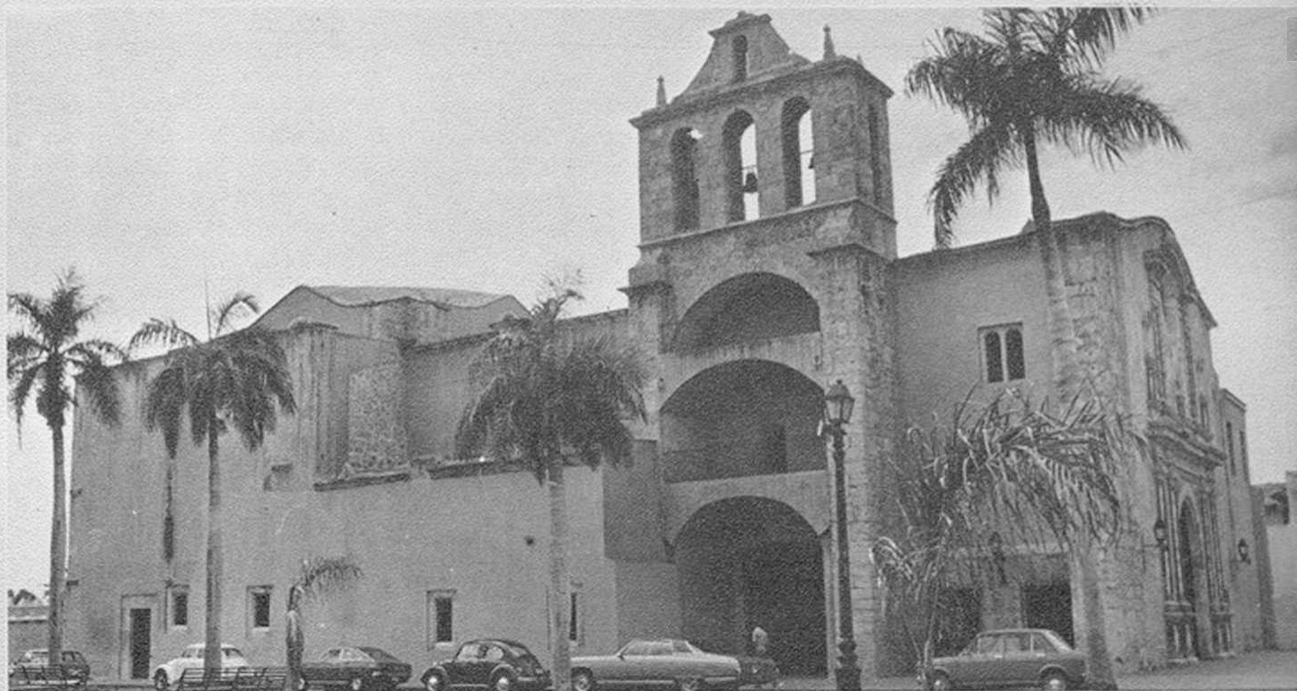
Fachada norte de la iglesia del Convento Dominicano
