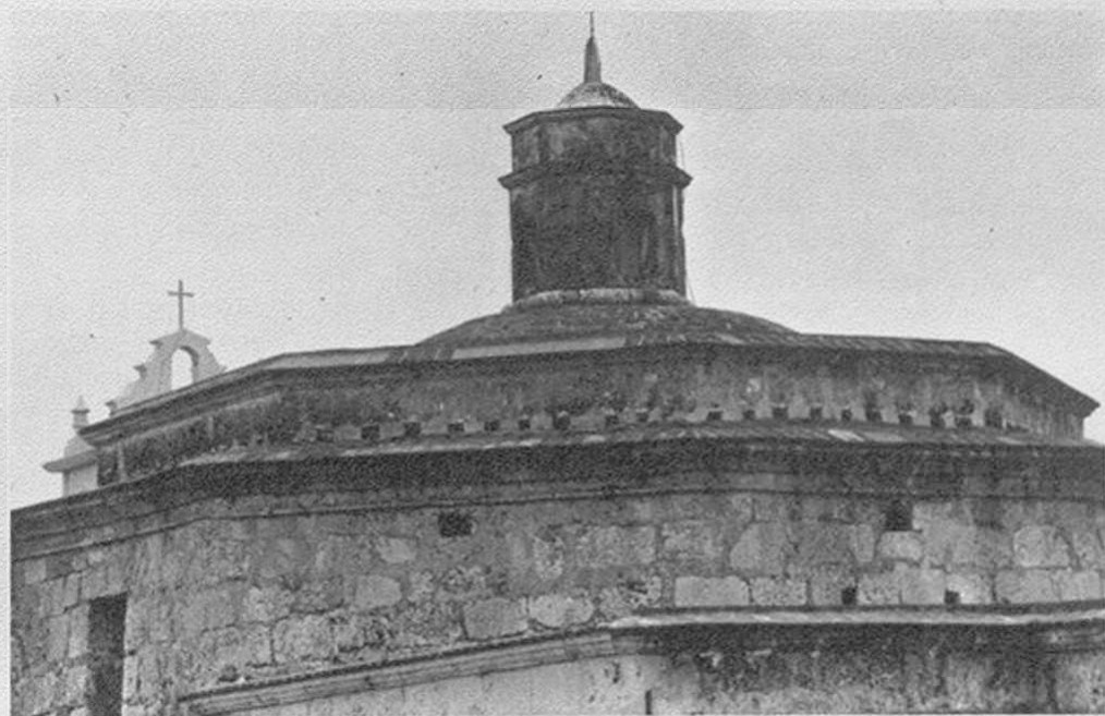
La linterna del techo de la iglesia se yergue enhiesta sobre la bóveda de crucería.
