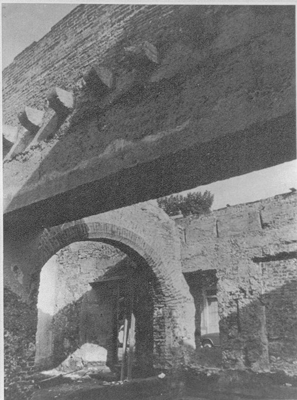
Amplio arco en ladrillo entre dos habitaciones del edificio.
