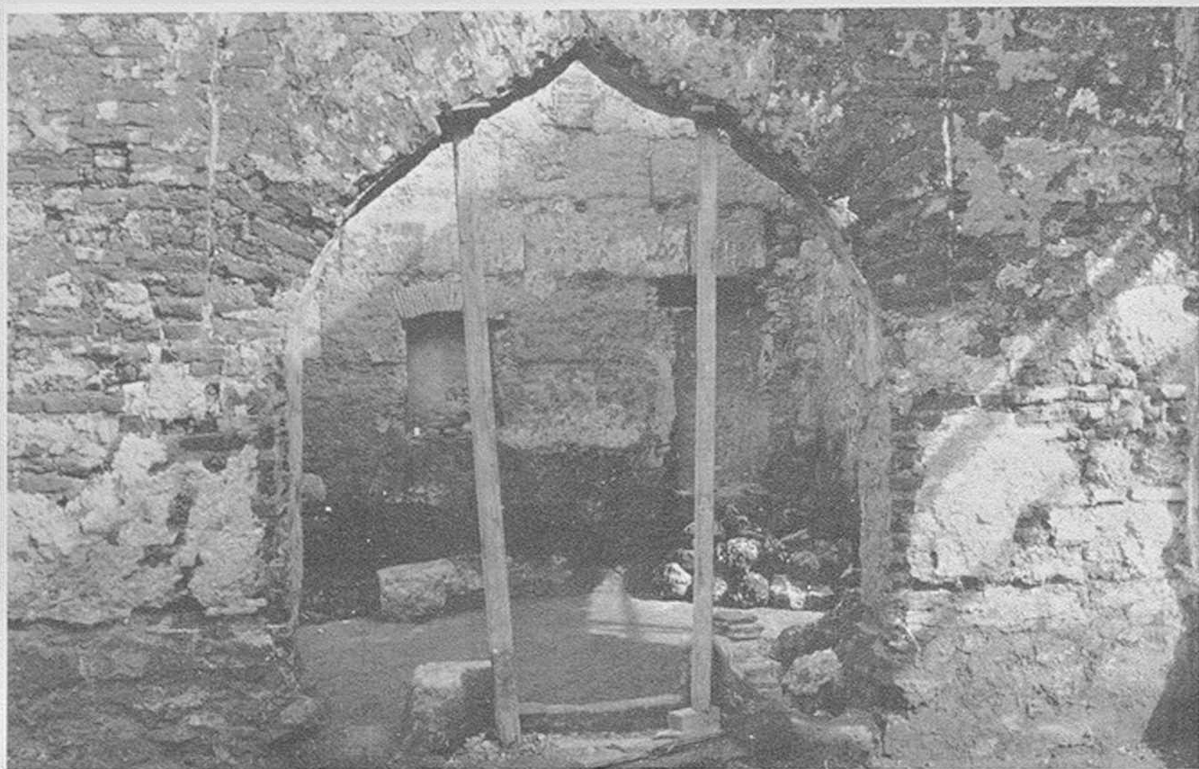
Un arco conopial de ladrillo surgió al eliminar el revoque moderno.
