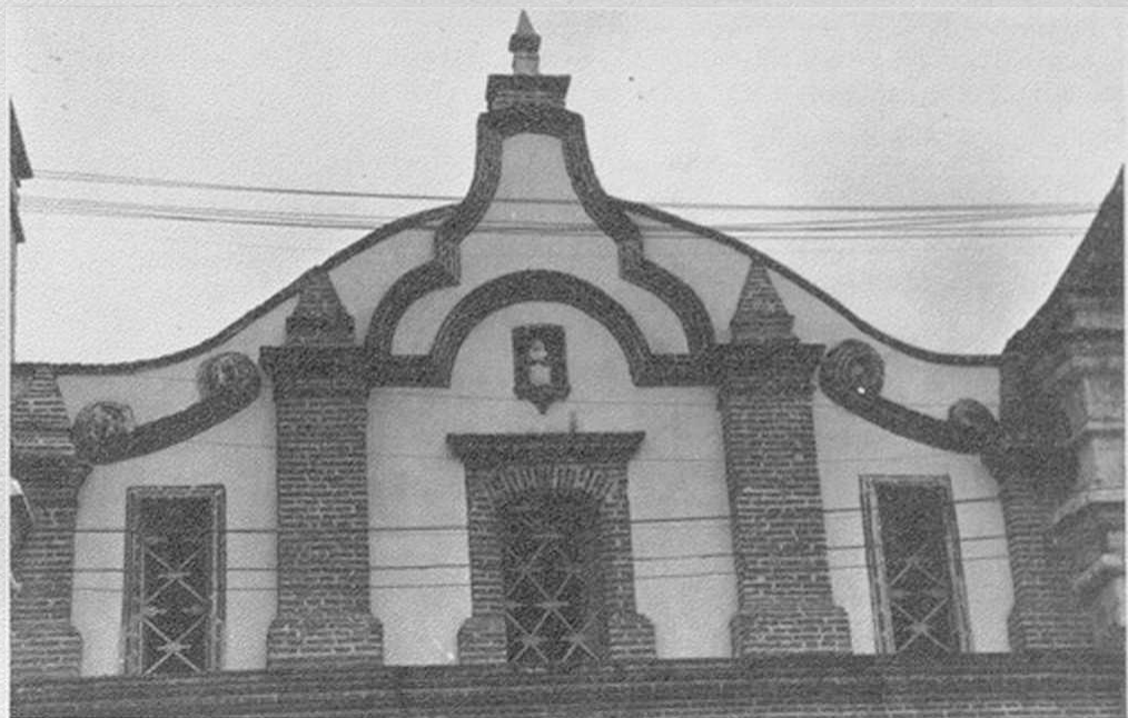
Detalle barroco, de movidas líneas, en la fachada de la iglesia.
