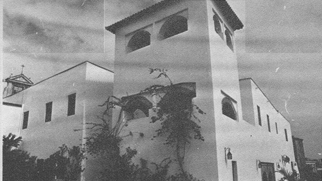
El torreón de tres cuerpos, reconstruido durante los trabajos de restauración.
