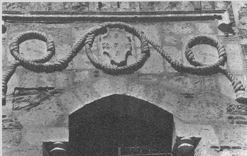
Detalle del portal del Convento con el cordón franciscano tallado en piedra con impresionante realismo.
