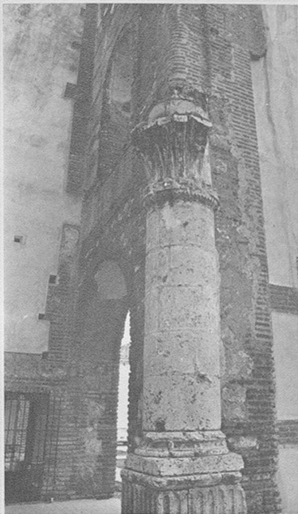
La columna adosada se levanta sobre una pilastra de estrías biseladas. El fuste liso sostiene un capitel en forma de dentellón.
