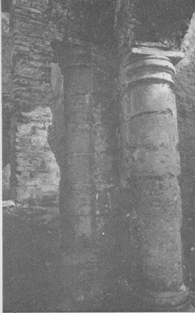
Las columnas del pórtico del patio se hallaban embebidas en el muro.
