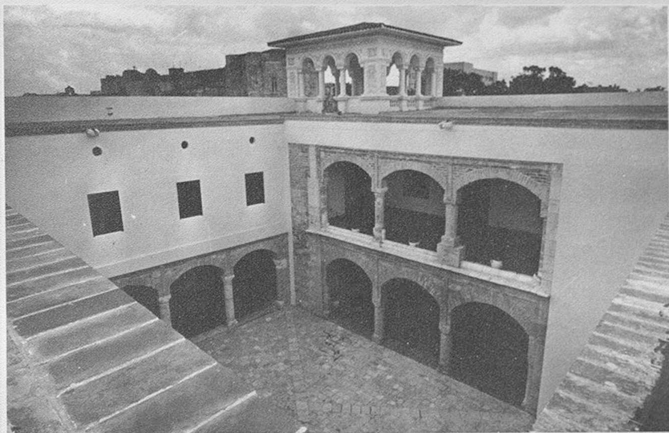
Patio típicamente colonial, con arcos de ladrillo sobre columnas de piedra.
