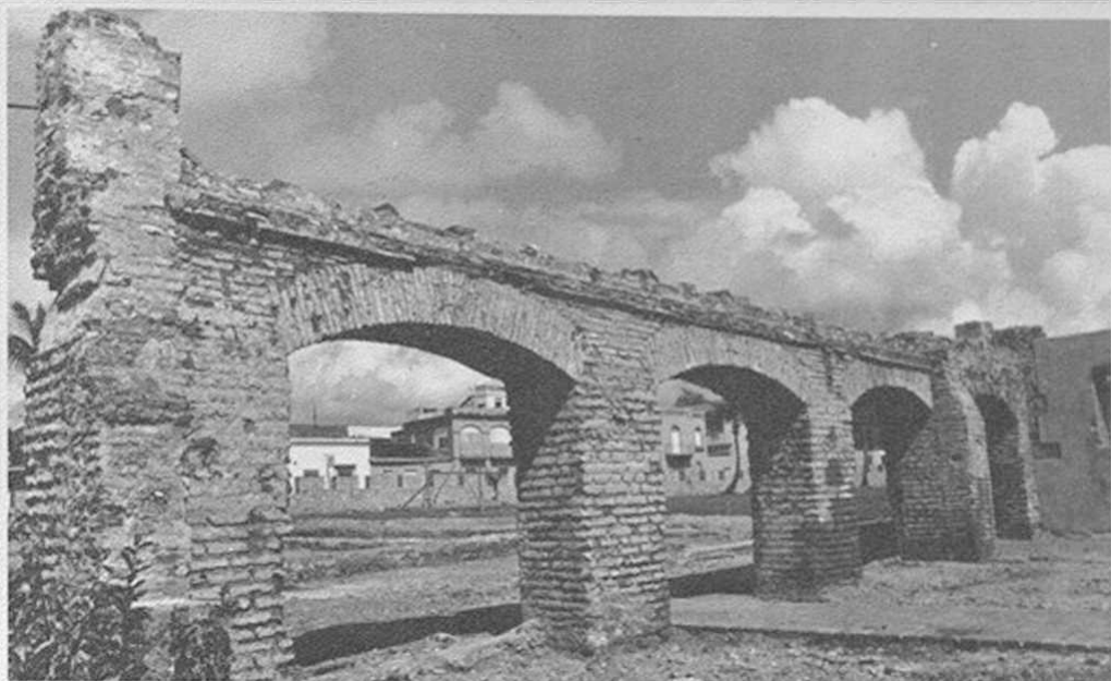
Arcos de ladrillo del Fuerte de Santiago aparecidos durante los trabajos.
