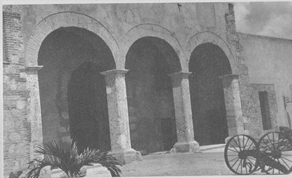
Estos arcos del portal estaban embebidos por muros modernos.
