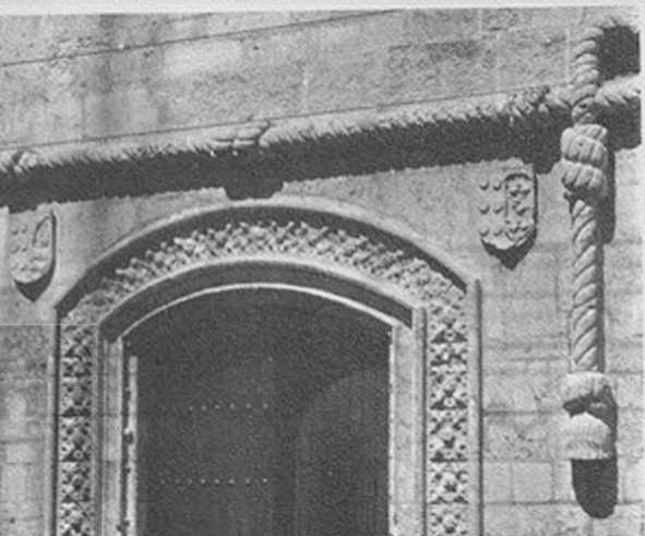
El cordón franciscano ennoblece la fachada de la antigua casona.
